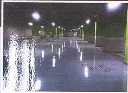
주거용건축물 아파트 지하 주차장
